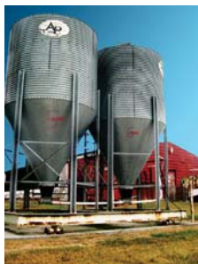
En la imagen se pueden ver dos silos de chapa ondulada galvanizada, de una explotación ganadera.
