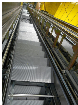
Reparación de escalera mecánica
