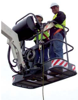
Maquinaria empleada en obra.
