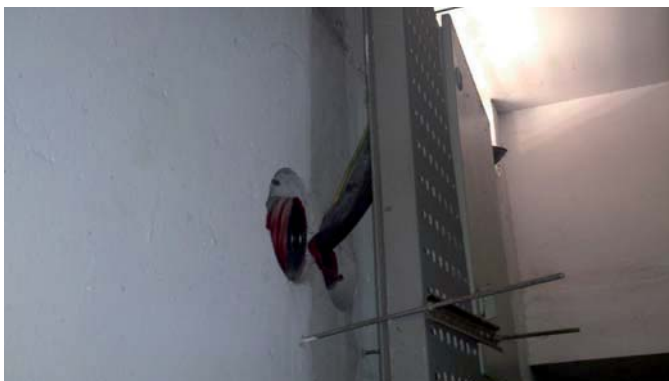
Línea general de alimentación de un edificio.
