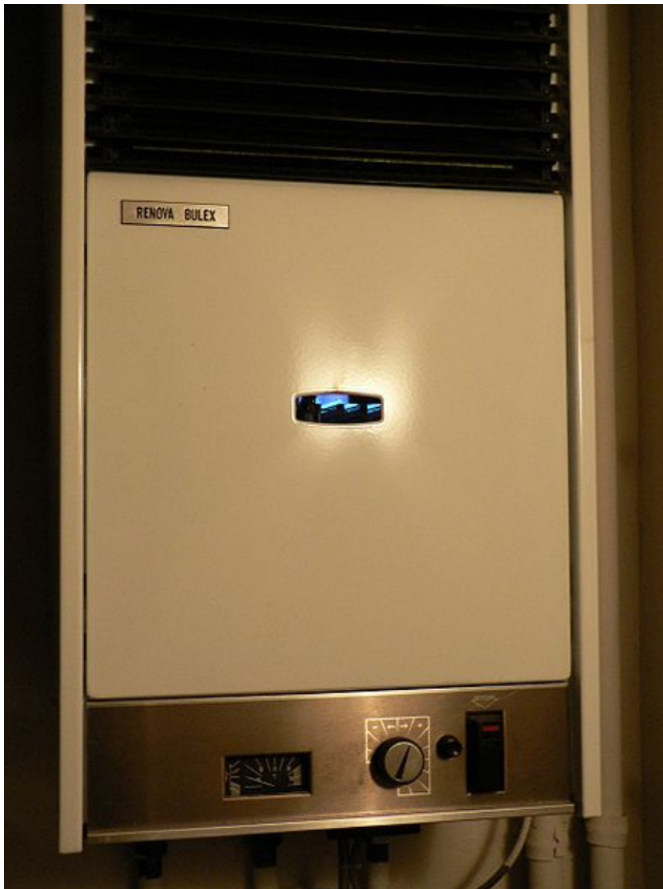
Caldera de gas para la producción instantánea de ACS
