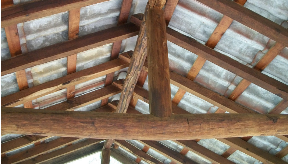
Detalle de estructura de madera y cubierta de fibrocemento
