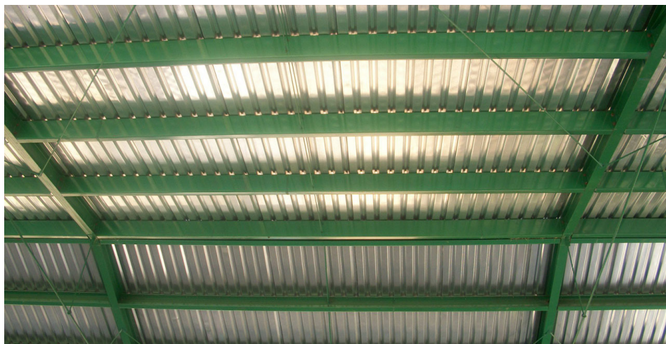
Detalle de estructura metálica y cubierta de chapa
